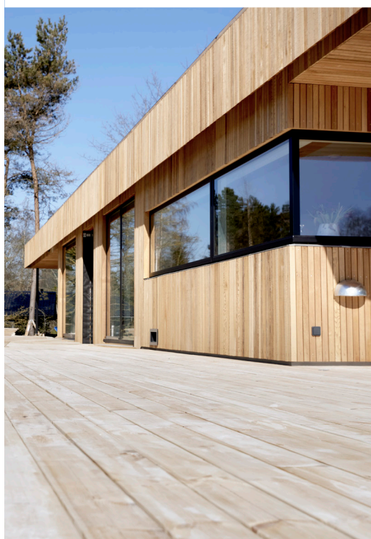
Project: Vakantiehuis, Norsminde | Sature terras
